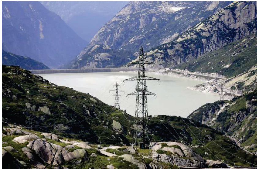
Die Stromleitung im Bahntunnel könnte die alternde Stromfreileitung über die Grimsel ersetzen. Foto: Peter Klauzner (Keystone)
